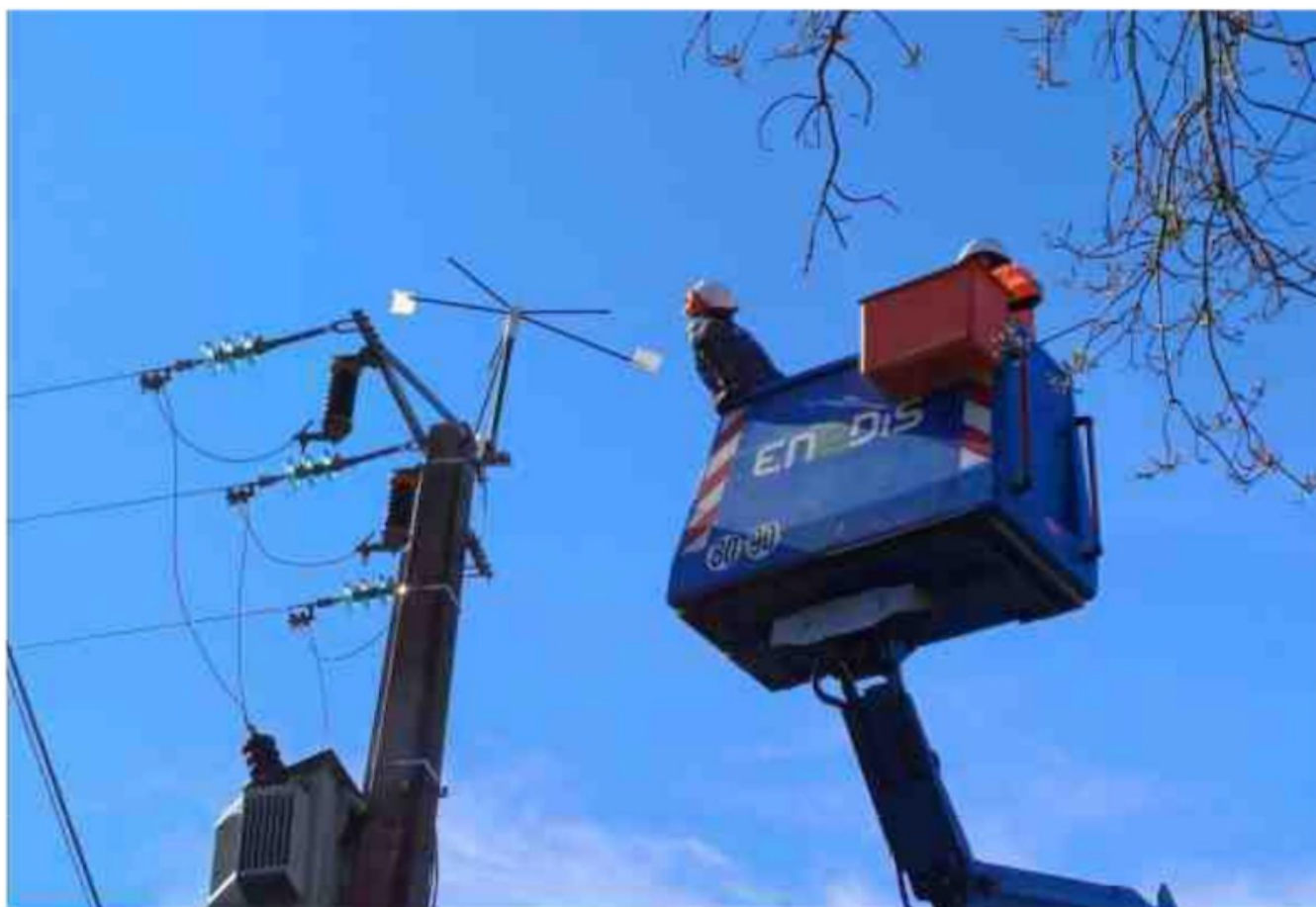
L'installation de la protection avifaune sur un poteau électrique. ENEDIS
