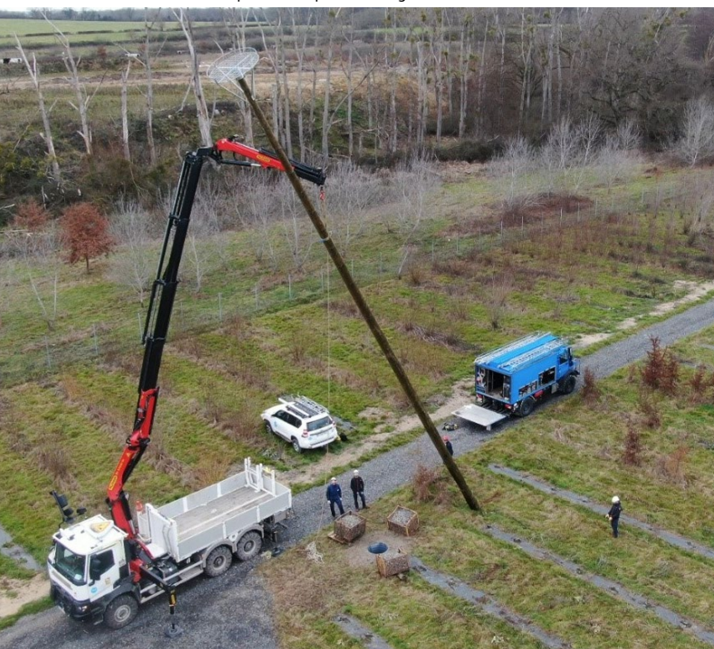
Photo 1 : Installation de la plateforme par camion-grue - © RTE
