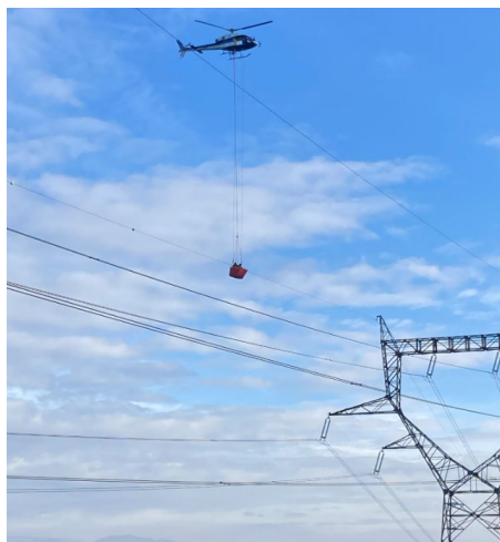
Le balisage du dit site par opération héliportée - © RTE
