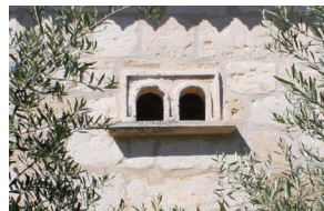
Ici deux nids ont été réalisés avec deux gabarits côte à côte
