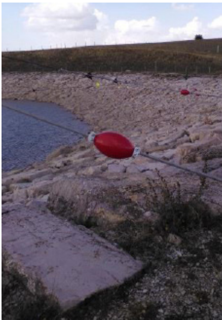
Photo 4: Impluvium avec clôture et fils à fladries
