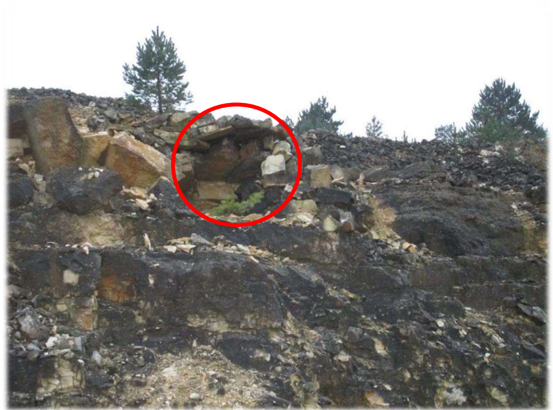
Photos 13 et 14 : Aménagement d'une cavité sur une carrière de roche dans la Meuse – 05/12/17 (E. Lhomer)
