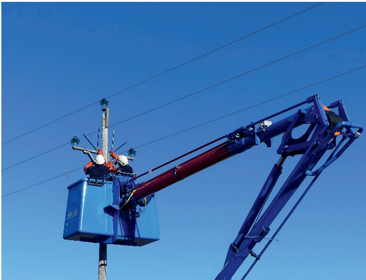
Mise en protection d'une ligne dans les Grands Causses par ENEDIS, chantier du 06 décembre 2017. Pose de balises Firely et de cierges © Léa Giraud
