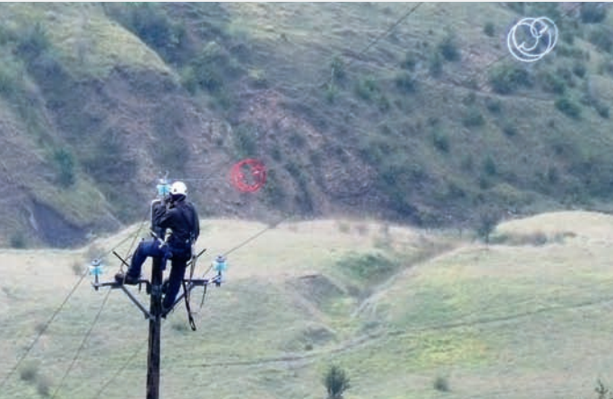
Pose d’équipements © LPO Grands-Causse
