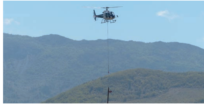
Travaux de neutralisation © Julien Traversier
