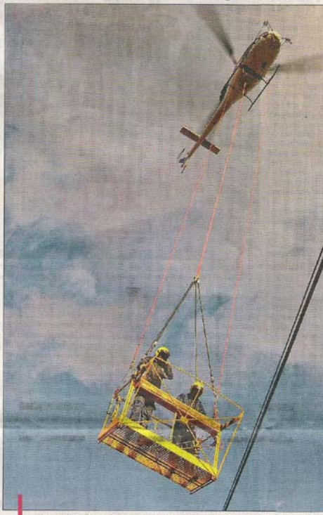
Au-dessus d'Auribeau, deux techniciens juchés sur une nacelle et portés par un hélicoptère s'en vont clipper sur les câbles électriques des balises de protection avifaunes. Ci-dessus, Patrice Perrot, directeur Vaucluse ERDF, et Benjamin Kabouche, directeur LPO PACA.
