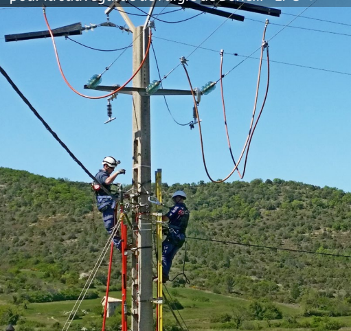
Ardèche - Neutralisation d'un support Enedis pour la sauvegarde de l'aigle de Bonelli - LPO ©
