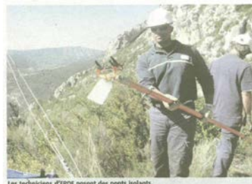
Les techniciens d'ERDF posent des ponts isolants.
