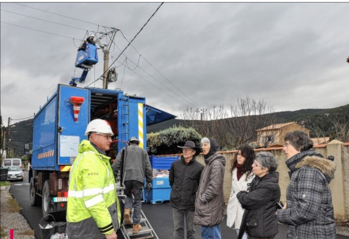
Le groupe électrogène a permis de garder le quartier alimenté durant les travaux sur le pylône.
