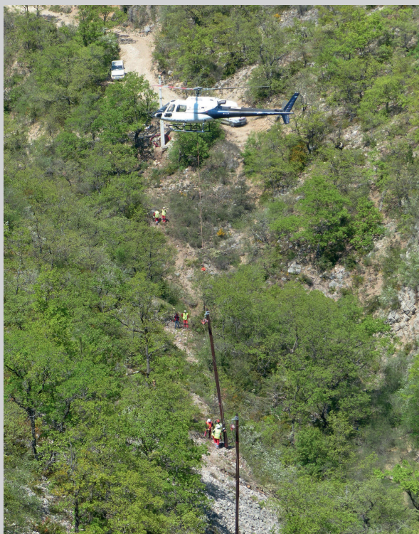
Travaux d'hélicoptage © VEB
