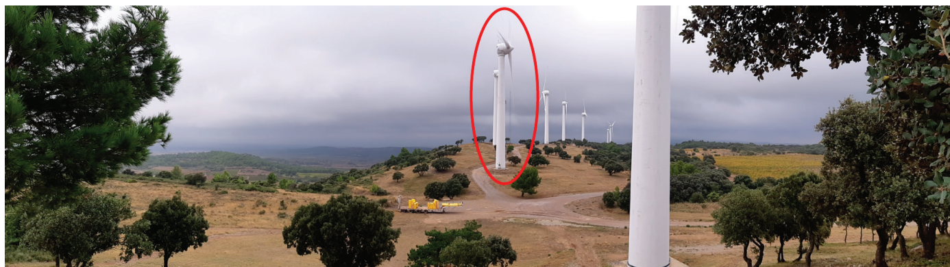
Photo2 - Eolienne du parc du Cers entre Escales et Conilhac-Corbières responsable de la mort de l'individu 5HR
