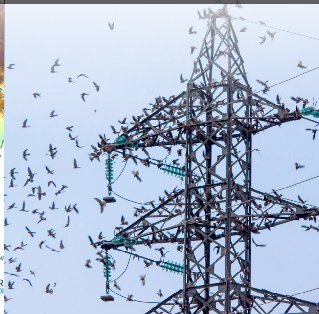
Figure 2 - Faucons crécerellettes en dortoir sur un pylône haute tension à Eyne - J. Jaurens ©
